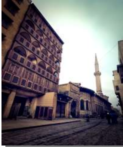
صورة رقم (1) توضح الواجهة المعمارية والمحاكاة الشكلية للبيئة المحيطة واستخدام الأرابيسك في تنفيذ الواجهة
